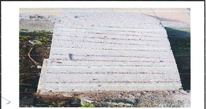
Foto 8: Nuevo Cuneta de concreto
