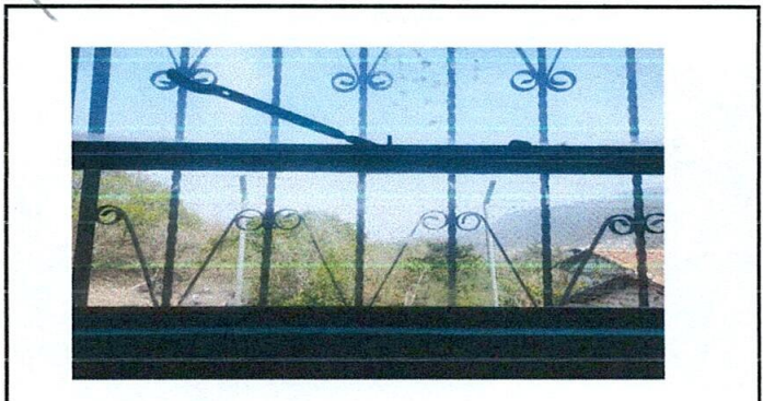
Foto 4: Nuevo vidrio de aula
