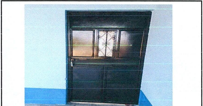
Foto 2: Mantenimiento de puerta realizado
