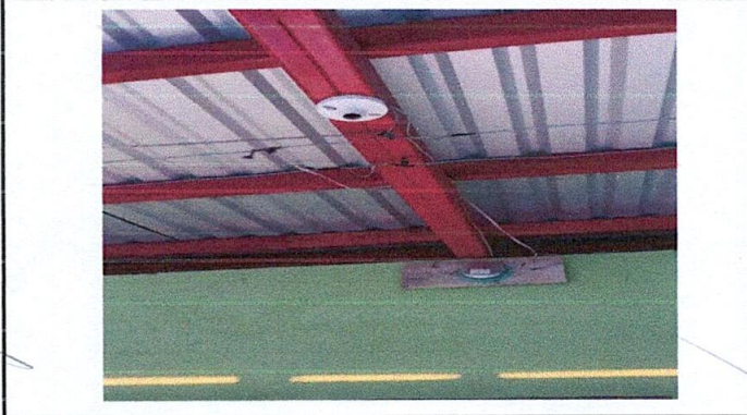
Sustitución de focos ahorradores
