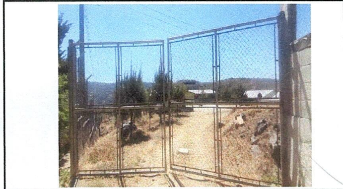
Sustitución de portón
