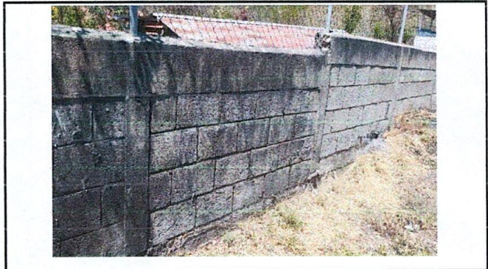
Reparación de muro perimetral
