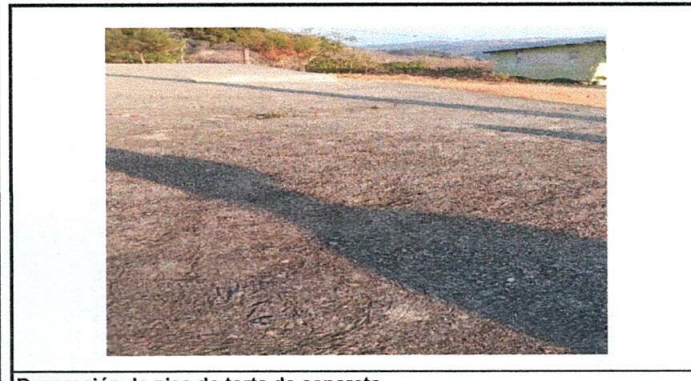
Reparación de piso de torta de concreto
