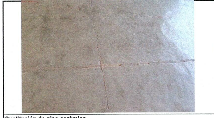
Sustitución de piso cerámico
