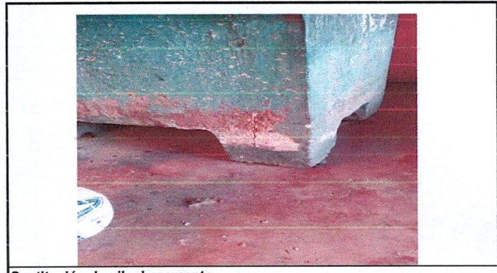
Sustitución de pila de cemento
