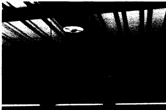
Sustitución de focos ahorradores
