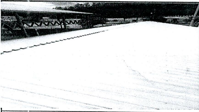
enlaminado de aulas
