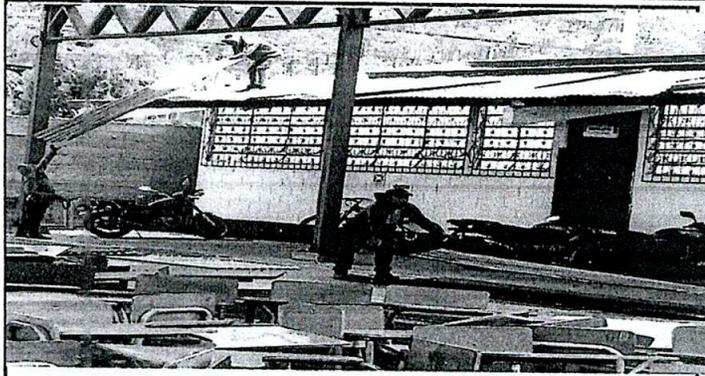
Foto1: Desmontada de lámina
