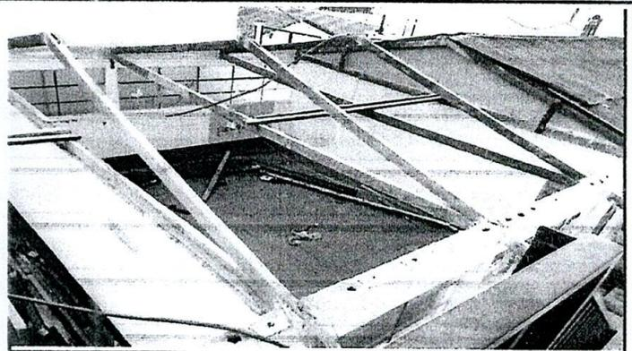
Foto 2: Desmontada de costaneras de madera por costaneras de metal y láminas
