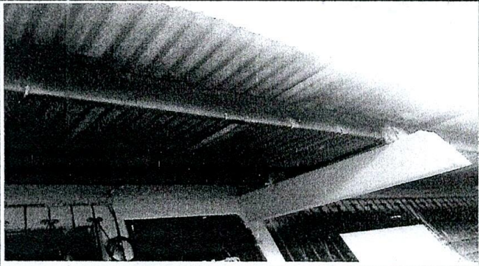
Foto 2: sustitución y pintado de costaneras y colocación de canales de metal
