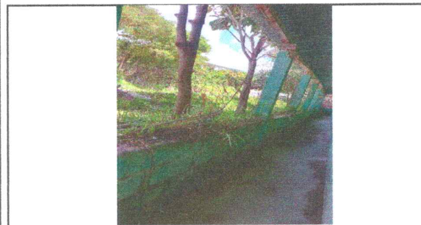
Foto 9: Reparación de muro perimetral de block y malla galvanizada
