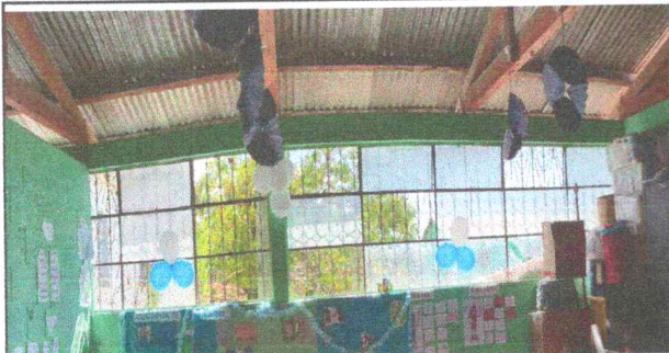
Foto1: Mantenimiento a estructura de metal de ventanas
