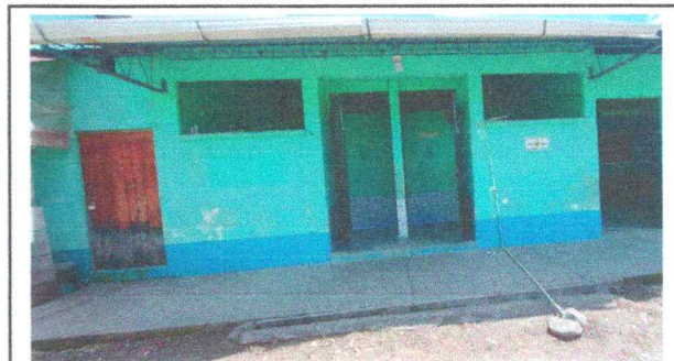
Foto 10: Pintura en muros exteriores e interiores (Baños)
