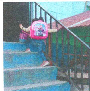
Foto 4: Sustitución de barandas de metal
