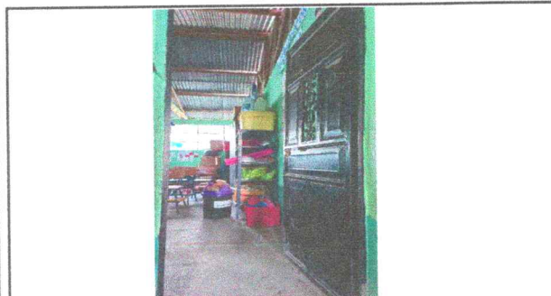
Foto 3: Mantenimiento a puertas
