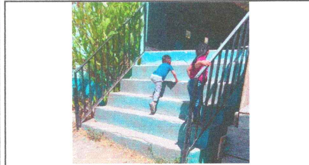
Foto 7: Sustrución de gradas de concreto por gradas de concreto más rampa
