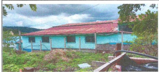
Sustrución de muro perimetral de block Foto 8: Sustrución de láminas, por lámina troquelada aluzinc calibre 26
