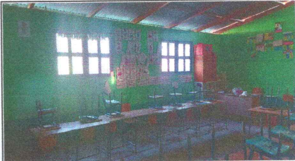
Foto 2: Sustitución de ventanas de madera por metal y vidrio
