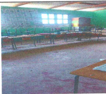
Foto 5: Sustitución de piso de cemento líquido por piso de granito
