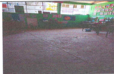
Foto 6: Sustitución de piso de concreto por piso de granito
