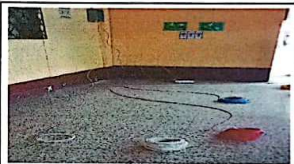
Foto 4: Reparación de cableado eléctrico
