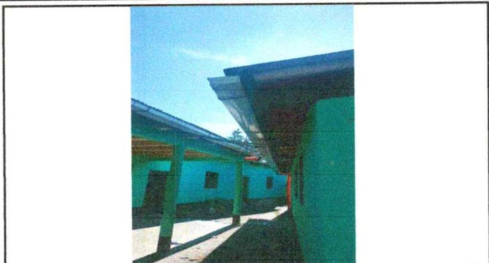
Foto 13: Sustitución de soporte o pescante de metal para canal
