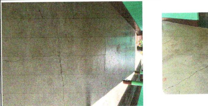
Foto 11: sustitucion de torta de concreto por piso granito
