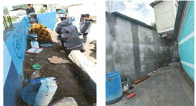
Reparación de muro de contención (ampliación)
