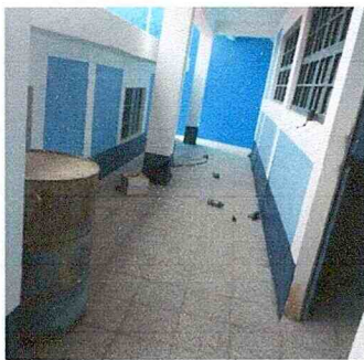
Colocación de piso de granito
