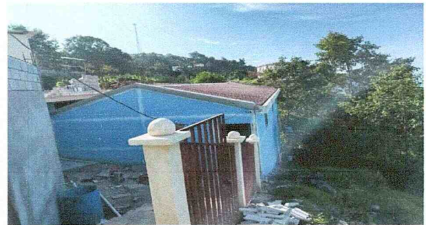
Colocación de losa de patio
