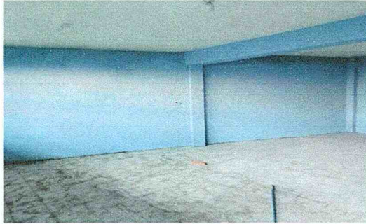
Pintura en muros interiores y exteriores
