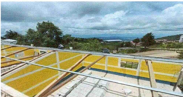
Sustitución de láminas y capotes
