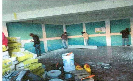
Mantenimiento en paredes
