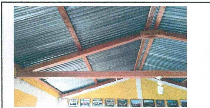
REPARACIÓN SISTEMA ELÉCTRICO
