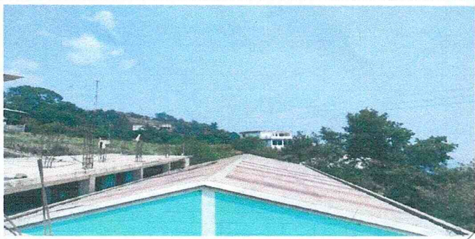
SUSTITUCIÓN DE LAMINA Y CAPOTES
