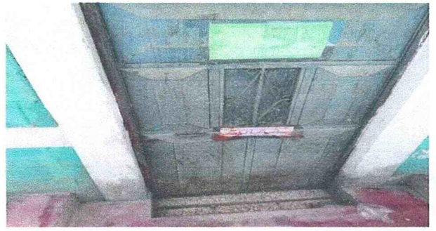
REPARACIÓN EN PUERTAS DE METAL (PINTURA Y CAMBIO DE CHAPA)
