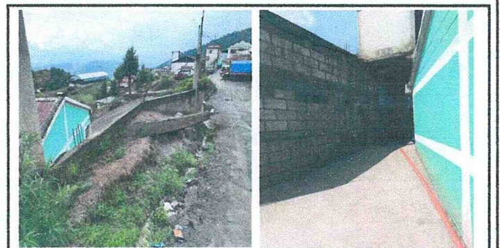
REPARACION DE MURO DE CONTENCIÓN (ampliación)
