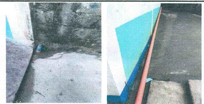
SUSTITUCIÓN DEL CANAL PVC
