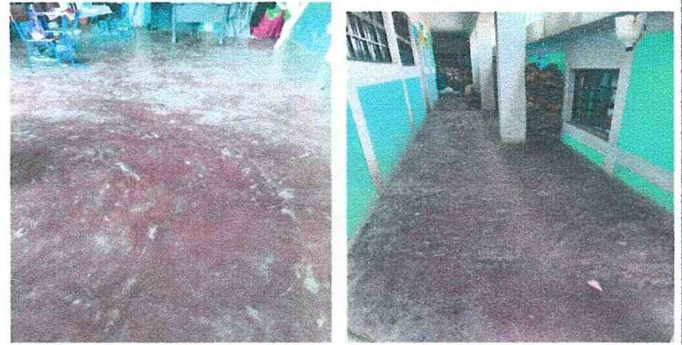
SUSTITUCION DE PISO DE TORTA DE CONCRETO.
