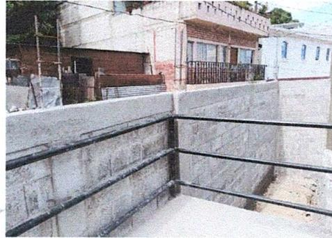
Foto 2: SUSTITUCIÓN DE MURO PERIMETRAL
