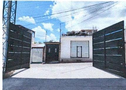
Foto 6: SUSTITUCION DE PORTÓN DE LAMINA A METAL
