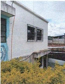
Foto 3: SUSTITUCIÓN DE PAREDES, ESTRUCTURA DE SOPORTE, LAMINA Y VENTANAS DE AREA ADMINISTRATIVA
