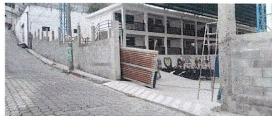
Foto 6: SUSTITUCION DE PORTÓN DE LAMINA A METAL
