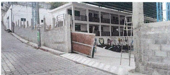
Foto 5: SUSTITUCION DE PORTÓN DE LAMINA A METAL
