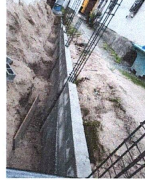
Foto 2: SUSTITUCIÓN DE MURO PERIMETRAL
