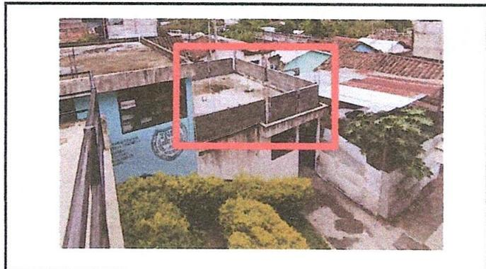
Foto 4: SUSTITUCION DE PAREDES, ESTRUCTURA DE SOPORTE, LÁMINA, Y VENTANAS DE AREA ADMINISTRATIVA
