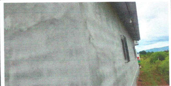
Foto 6: Pintura de paredes interiores y exteriores
