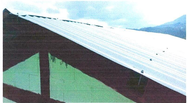
Foto 2: ya se encuentra con laminas nuevas el techado de la direccion del centro educativo
