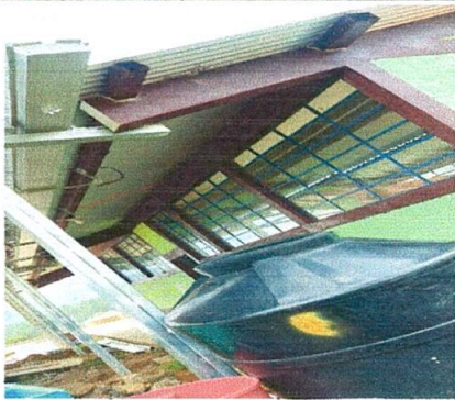
Foto 3: Sustitucion de Canales en el centro educativo
