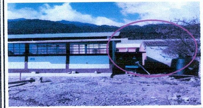
Foto 3: DEPOSITOS DE AGUA, SUSTITUIR DEPOSITO DE AGUA PARA RECEPCION DE AGUA PLUVIAL
