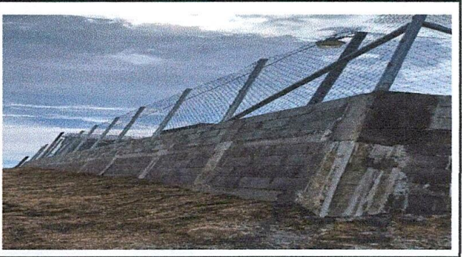
Muro de contención de (5 hiladas) y muro perimetral con block normal (4 hiladas)
