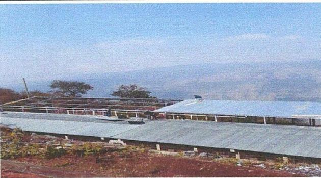
Foto 5: Sustitución de láminas por laminas troquelada.
