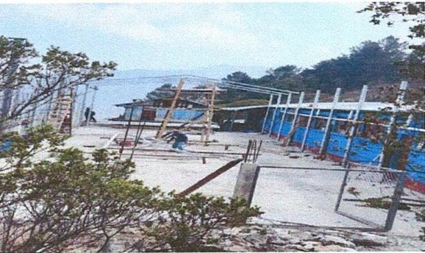
Foto 3: Sustitución de parales por tubos de metal .
