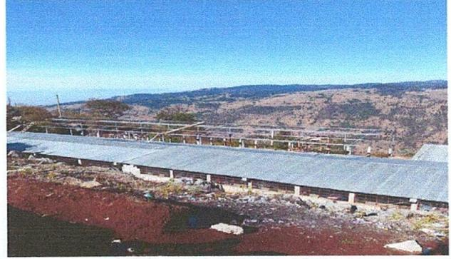
Foto 4:Sustitución de estructura de soporte por metal
