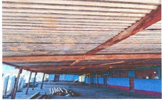
Foto 2: Láminas y vigas en mal estado
