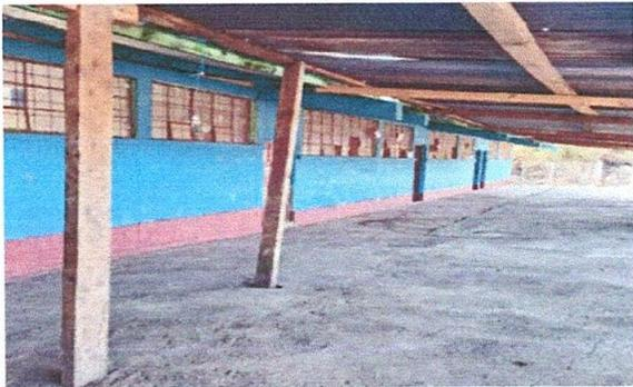
Foto 3: Los parales de madera y láminas por el paso de los años y las inclemencias del tiempo se han deteriorado.
