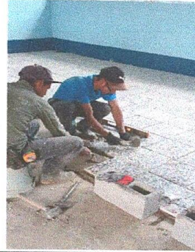
Foto 2: Colocación de Piso granito
