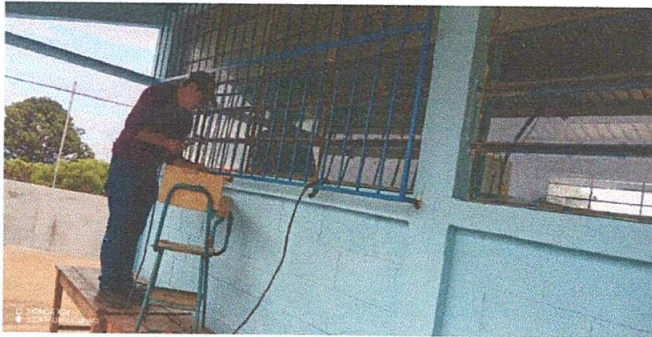
Foto 3: Fabricación de Balcones para ventana
