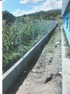
Foto 2: Repello en paredes de muro perimetral
