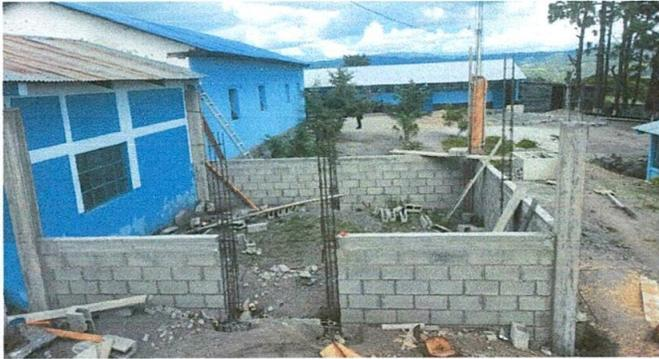
Foto 1: Reforzamiento en paredes de muro de cocina
