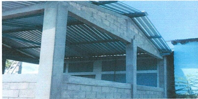
Foto 5: Cocina sin ventanas
