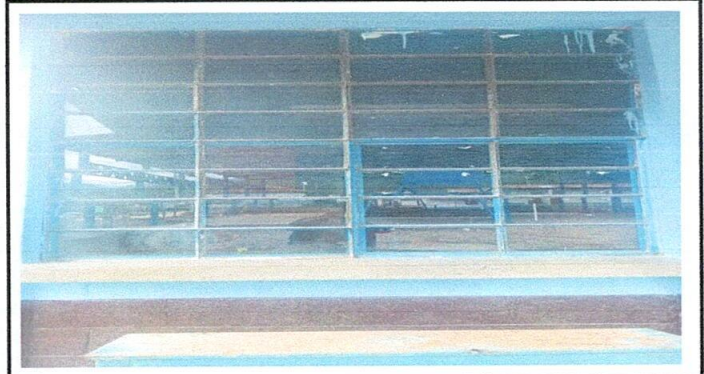
Foto 4: Ventanas sin balcones
