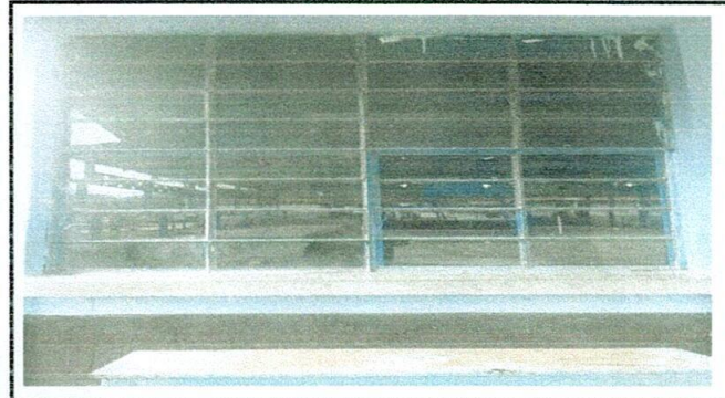
Foto 4: Ventanas sin balcones
