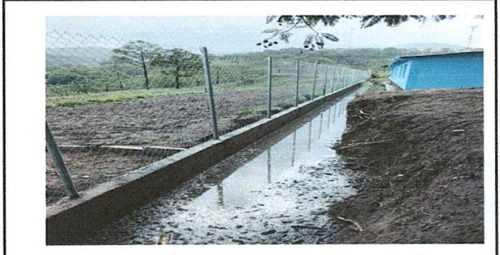
Foto 2: Repello en paredes de Muro
