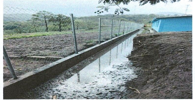
Foto 2: Repello en paredes de Muro
