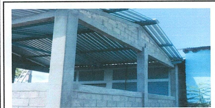
Foto 5: Cocina sin ventanas
