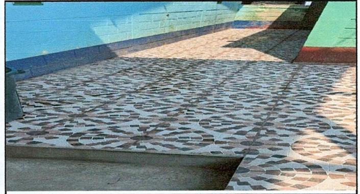
Foto 4: Piso cerámico antideslizante instalado en el patio de los baños.
