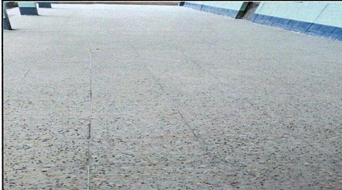
Foto1: Piso granito instalado
