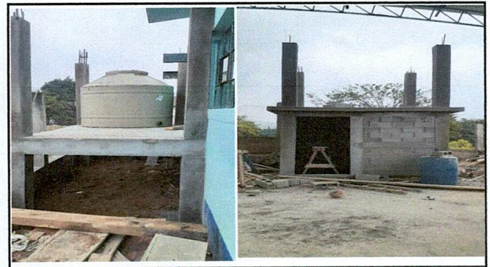
Foto 4: Construcción de bases para depósito de agua.
