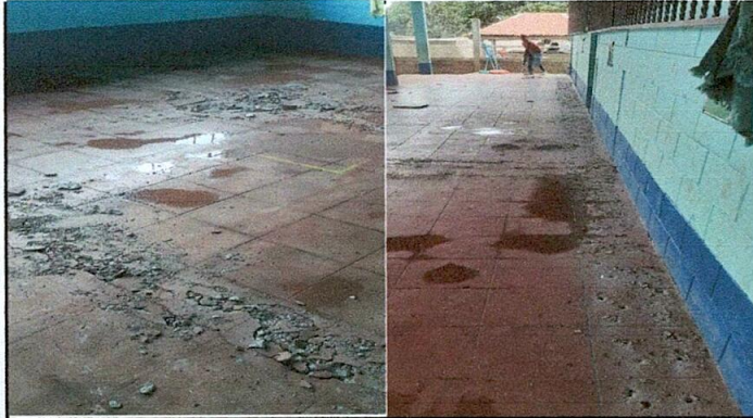
Foto1: Sustrucción de piso por piso granito.
