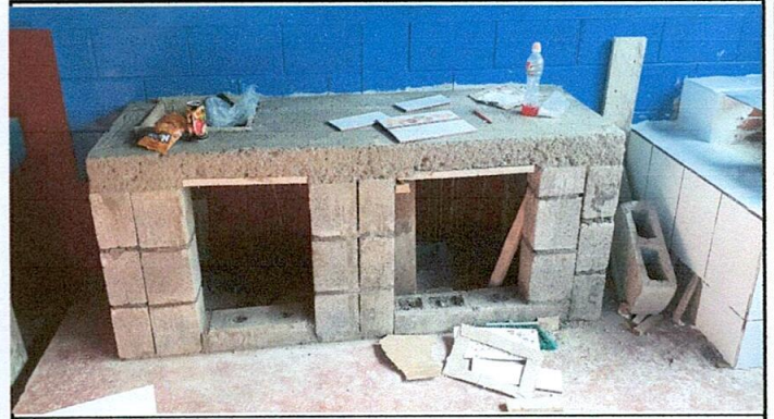
Foto 2: Construcción de lavatrastos
