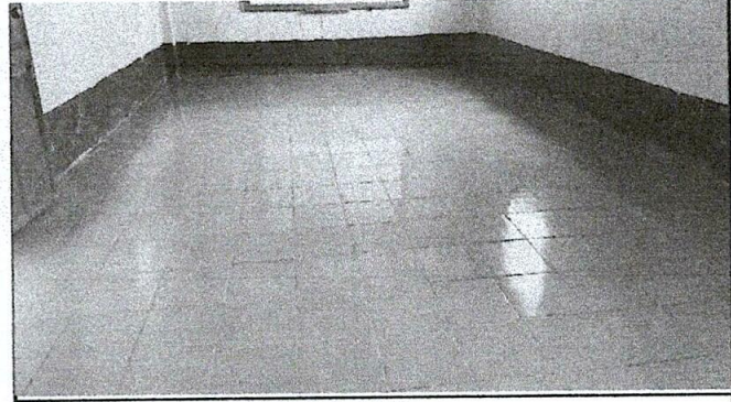
Foto 4: piso nuevo ya instalado en el aula
