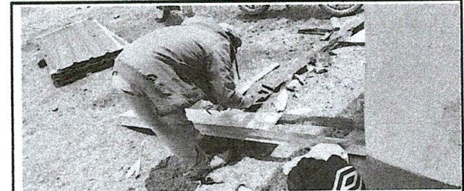
Foto 6: preparando materiales para instalaciosn de canales y vidrios
