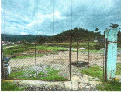
FOTO 1: Sustrucción de portón
