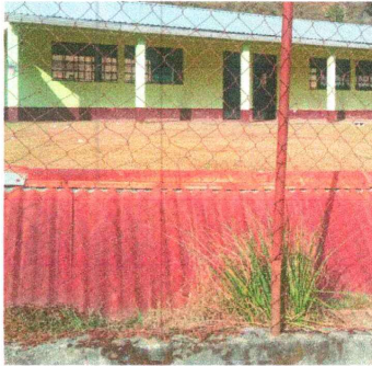
FOTO 3: reparación de tubo perimetral
