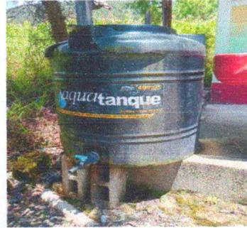
Foto 10: Sustitucion de deposito de agua de 1,700 litros
