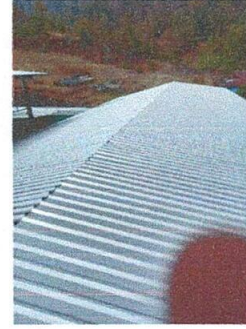
Foto 2: Finalización en la colocación de lámina troquelada
