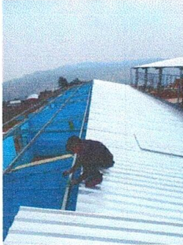
Foto 1: Sustitución de techado
