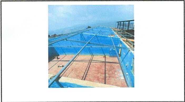
Foto 1: Sustitución de techo
