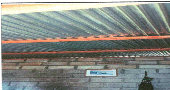
Foto 3: Sustitución de estructura del techado de madera por metal
