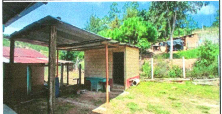
Foto 8. Sustitucion regla de madera por costaneras area de cocina, la parte de frontal tambien se usa para cocinar por tener una cocina pequena, que es lo que ve al fondo.
