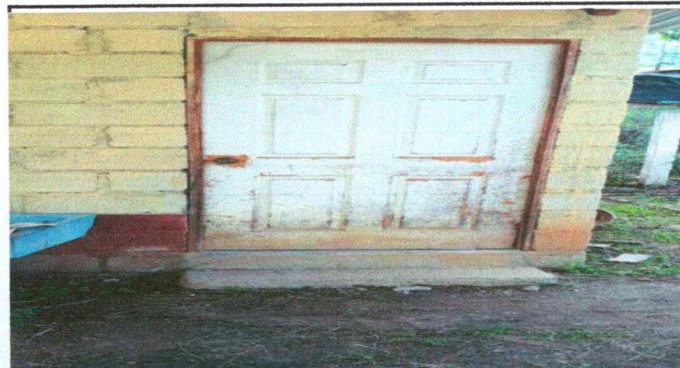
Foto 4: Sustitución de puerta de madera por metal
