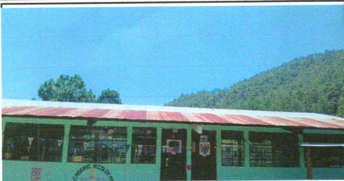
Foto1: Sustitución de lámina por lamina tioquelada aluzinc calibre 26
