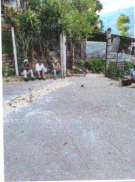
Foto 1: Sustrucción de porton de metal
