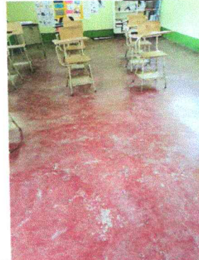
Foto 2: Sustrucción de piso de concreto por piso granito
