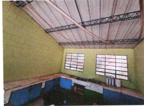
Foto 2: Sustitución de azulejo en muebles de cocina
