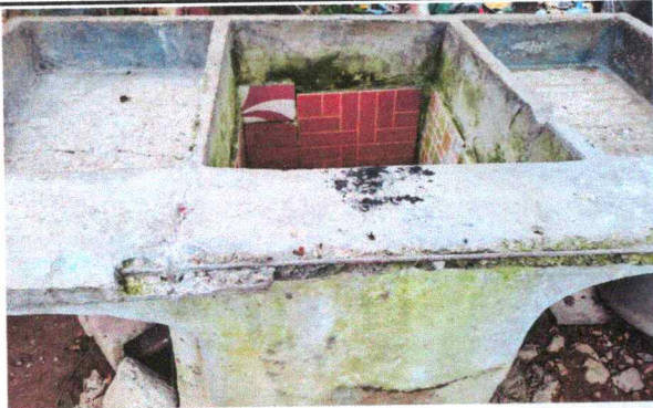
Foto 3: Sustitución de pila de cemento de dos lavaderos
