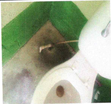
Foto 3: Sustrucción de inodoros
