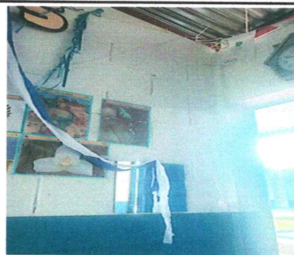
Foto 20: 17.11 sustitucion de ducto electrico + accesorio
