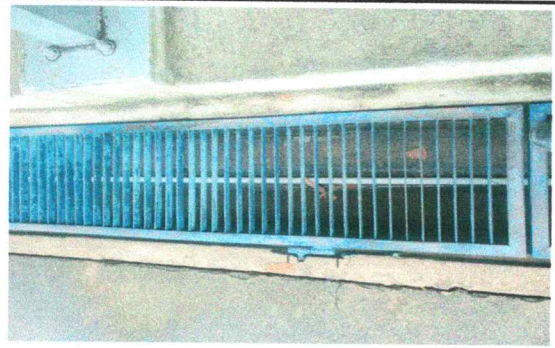
Foto 10: 8.1 Mantenimiento de parrilla de cuneta
