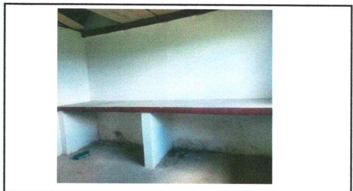
Foto 16: 20.8 Mejoramiento de azulejo en muebles de cocina
