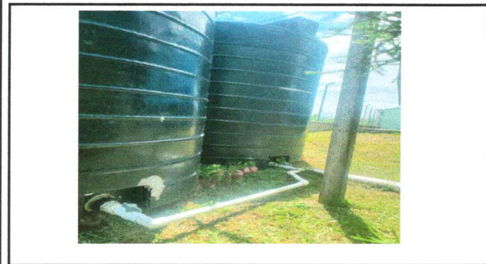
Foto 15: 18.3 Sustitución de deposito de agua 2, 500 lt
