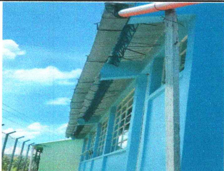
Foto 5: 7.1 sustitución de canal de metal
