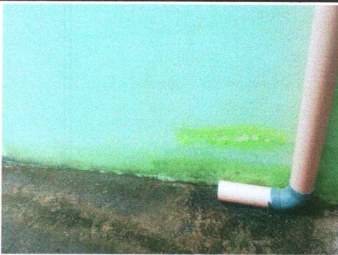
Foto 11: pintura en muros exteriores e interiores
