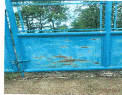
Foto 2: 12.1 Mantenimiento a portones de metal
