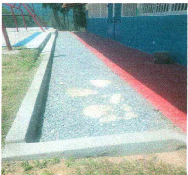
Foto 21: 6.1 Reparación de piso concreto
