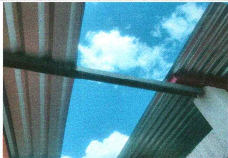
Foto 23: 2.4 sustitucion de estructura de metal, por metal
