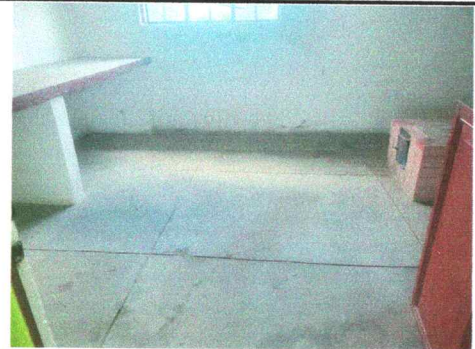
Foto 4: 6.8 sustitución de piso granito
