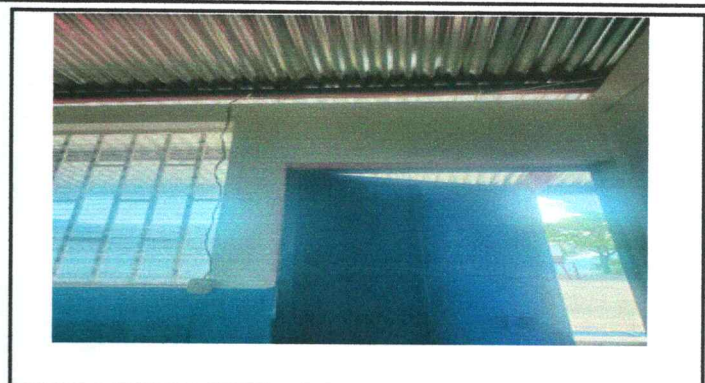
Foto 14: 17.11 Reparación de cableado electrico
