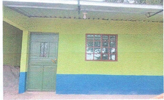
Foto 2: sustitucion de puerta
