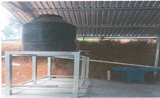
Foto 3: sustitucion de las bases de tiancos
