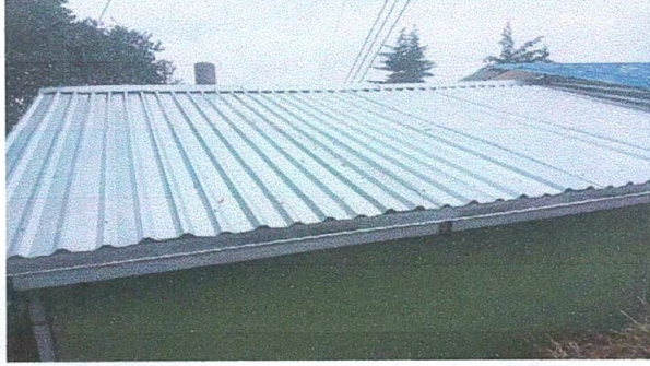
Foto1: Sustitucion de lamina
