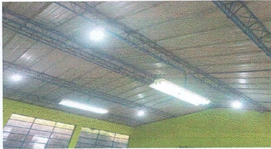
Foto 5: Reparacion del sistema electrica
