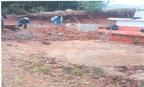
Foto 5: Reparacion para el piso de concreto.
