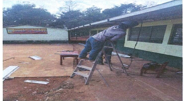
Foto 2: sustitucion de canales
