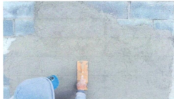
Foto 6: aplicacion de repello.
