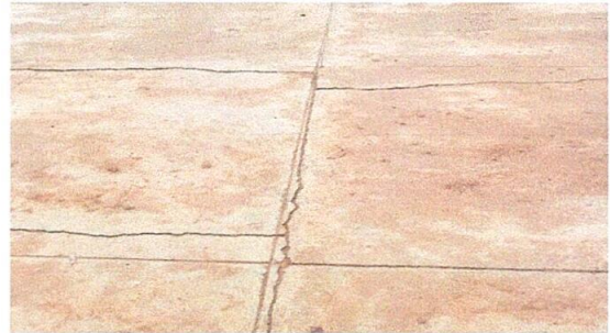
SUSTITUCION DE PISO DE TORTA DE CONCRETO.
