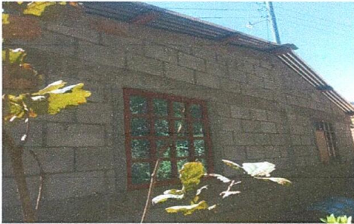
SUSTITUCION DE ESTRUCTURA DE METAL DE VENTANAS
