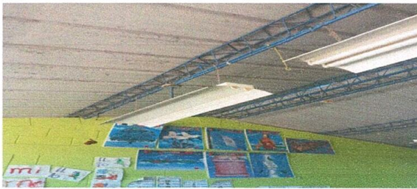
REPARACION DEL SISTEMA ELECTRICO.
