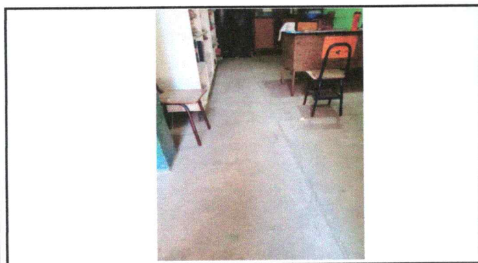
Foto 9: Sustitución de piso de Dirección
