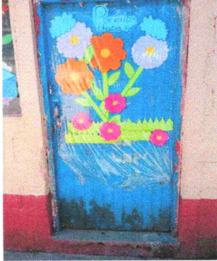
Foto 25: Sustitución de puerta de aula 2
