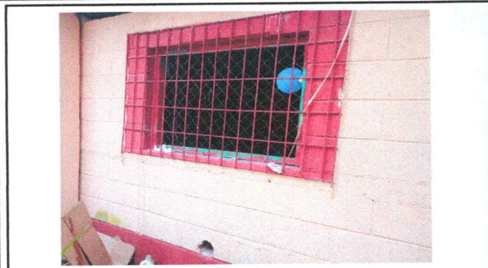
Foto 19: Sustrucción de ventana de aula 1
