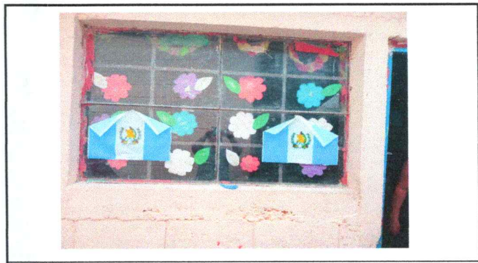
Foto 10: Mejoramiento de balcón de ventana de aula 2
