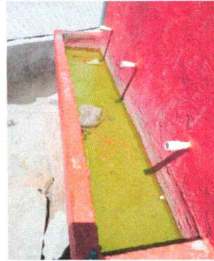
Foto 16: Sustitución de lavamanos de concreto por lavamanos individual
