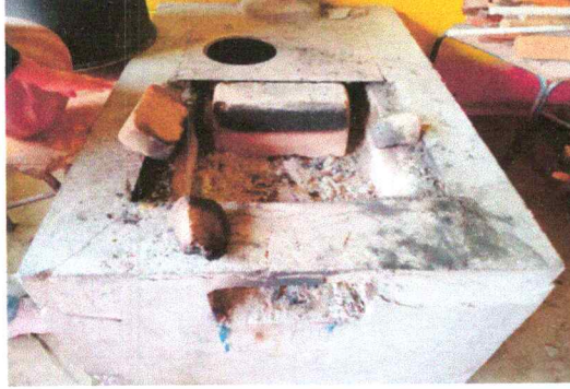
Foto 13. Sustitución de estufa rural (completa) incluye chimenea y plancha de metal
