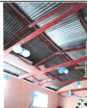
Foto 4: Sustitución de estructura de aula 2
