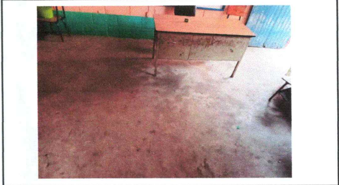
Foto 8: Sustitución de piso de aula 1
