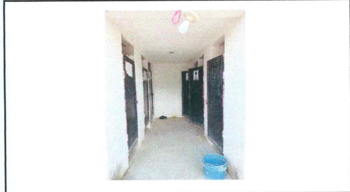
Foto 20: Mejoramiento de azulejo
