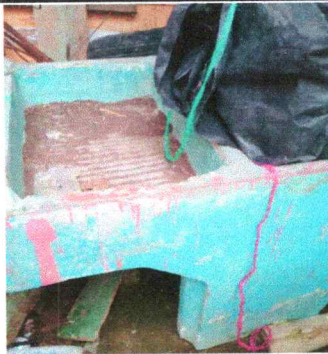
Foto 17: Sustitución de pila plástica de dos lavaderos
