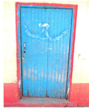
Foto 26: Sustitución de puerta de aula 1
