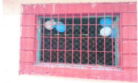
Foto 14: Sustitución de ventana 2
