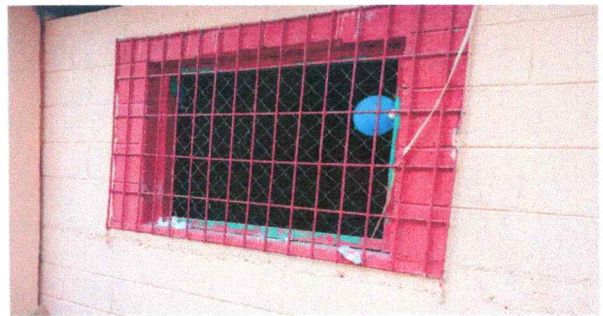
Foto 18: Sustitución de balcón del aula 1
