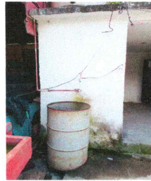
Foto 28: Sustitución de red de drenajes y red de agua potable
