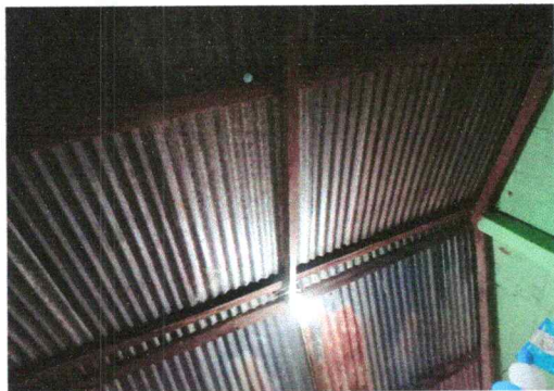
Foto1: Sustitución de techo de aula 1
