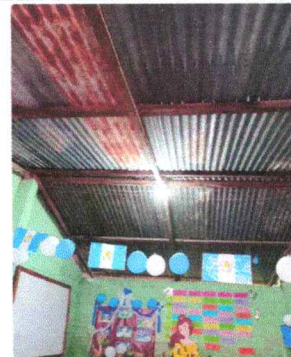
Foto 2: Sustitución de techo de aula 2
