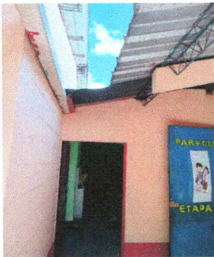
Foto 27 Mejoramiento de canales y bajadas de agua pruvial
