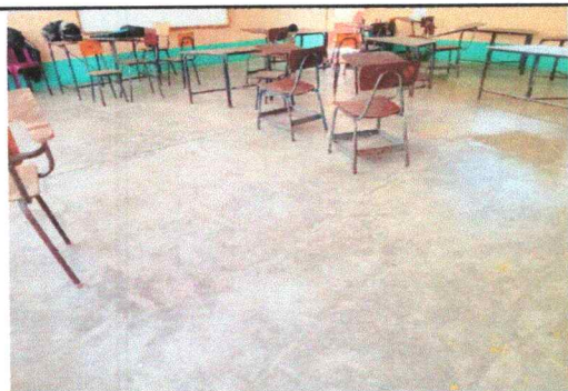
Foto 5: Sustitución de piso de aula 4
