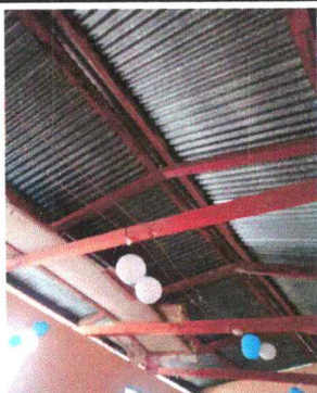
Foto 3: Sustitución de estructura de aula 1
