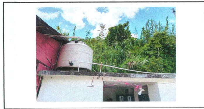
Foto 12: Sustitución de depósito de agua
