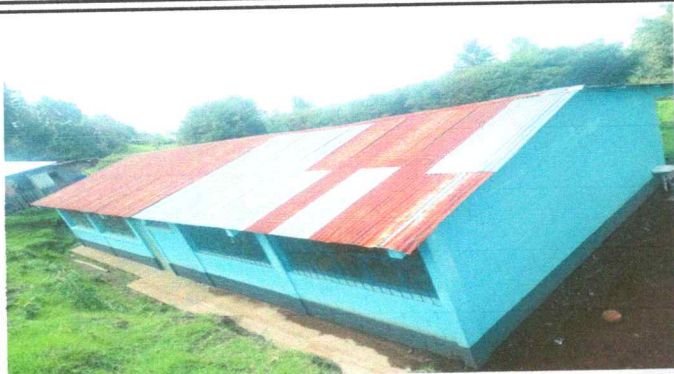
Foto1: SUSTITUCION DE LAMINAS POR LAMINAS TROQUELADAS
