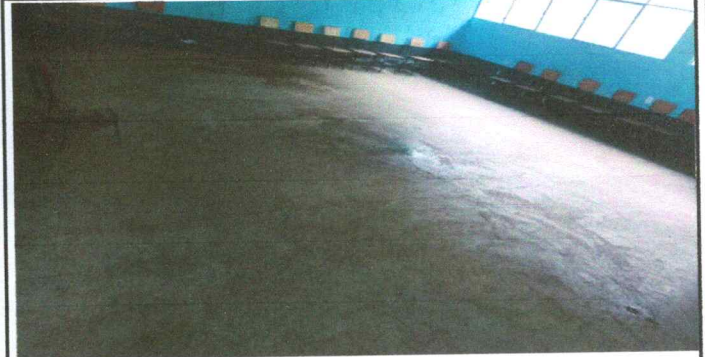
Foto 2: SUSTITUCION DE PISO DE TORTA DE CONCRETO
