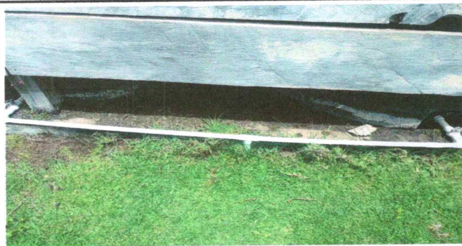
Foto 6.2 : RED DE AGUA POTABLE SUSTITUCION DE TUBERIA LINEA PRINCIPAL
