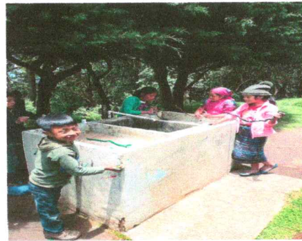
Foto 7 SUSTITUCION DE PILAS DE CEMENTO DE DOS LAVADEROS
