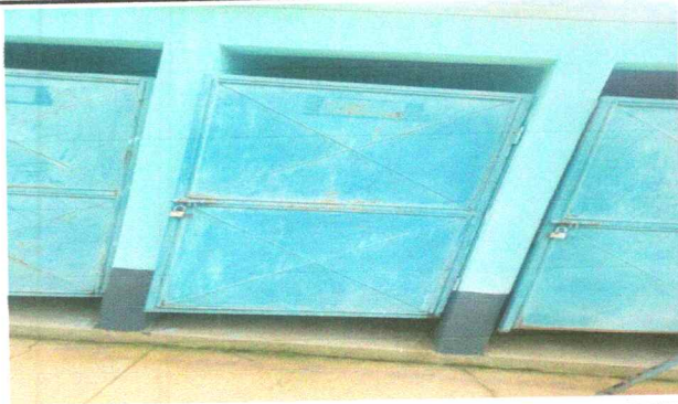
Foto 3: SUSTITUCION DE PUERTAS EN SERVICIO SANITARIO
