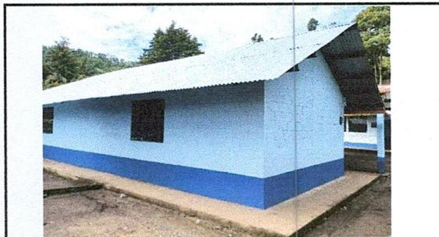
Foto 5: Sustitución de lámina por lámina acanalada calibre 26
