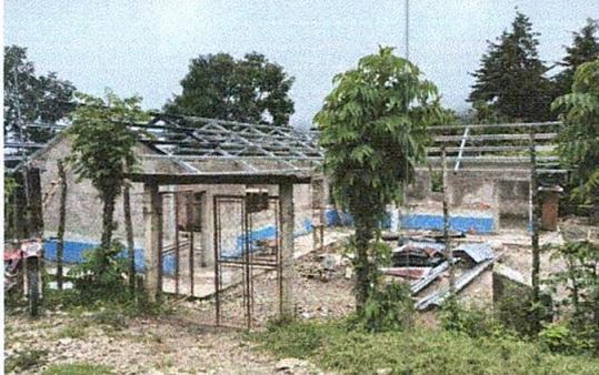
Foto 1: Sustrucción de estructura de soporte de madera por metal
