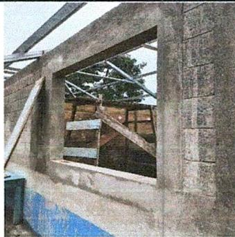
Foto 3: Sustrucción de ventanas de madera por metal más vidrio
