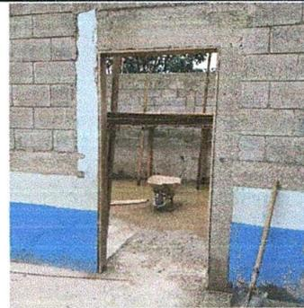
Foto 4: Sustrucción de puertas de madera por metal
