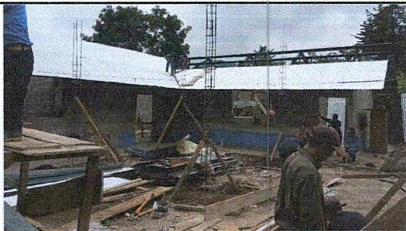
Foto: Sustrucción de lámina por lámina acanalada calibre 26
