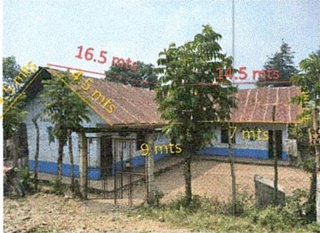
Foto 1: Lámina y estructura de soporte de madera en malas condiciones
