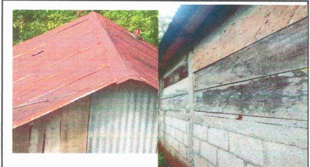
Foto 1: CUBIERTA DE LAMINA. Sustritucion de láminas por laminas troquelada
