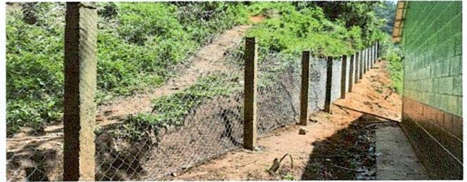
Foto No. 8: Reparación de columna de concreto y sustitución de malla galvanizada finalizado
