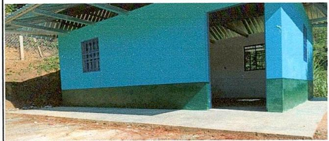
Foto No. 6: Piso de torta de concreto más alisado terminado
