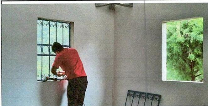
Foto No. 5: Instalación de ventanas de metal más vidrio
