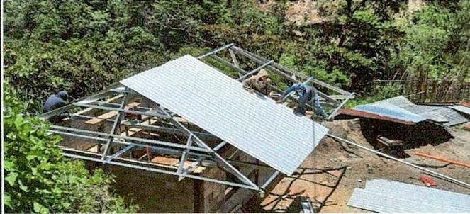
Foto No. 1: Instalación de cubierta de lámina
