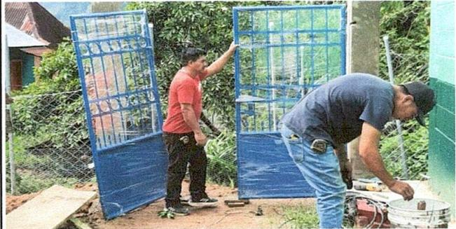
Foto No. 4: Instalación del portón de metal
