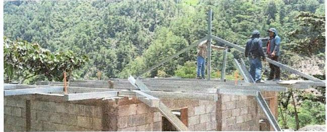
Foto No. 2: Instalación de estructura techo de metal
