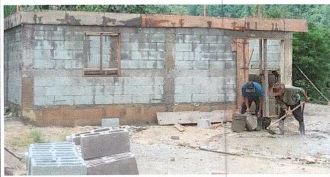
Foto No. 9: Paredes de block y soleras intermedias en proceso de mejoramiento
