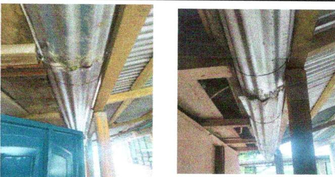
Foto 5: Canales de agua no adecuado para la lluvia
