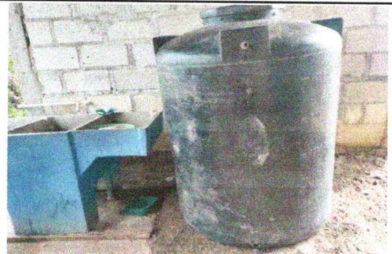
Foto 4: Deposito de agua en mal estado.
