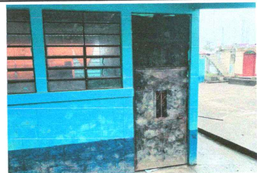
Foto 6: Pintura en muros exteriores e interiores
