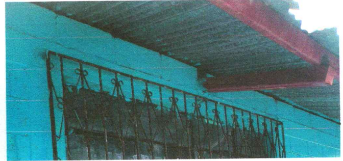
Foto 2: Mantenimiento de estructura de soporte de metal
