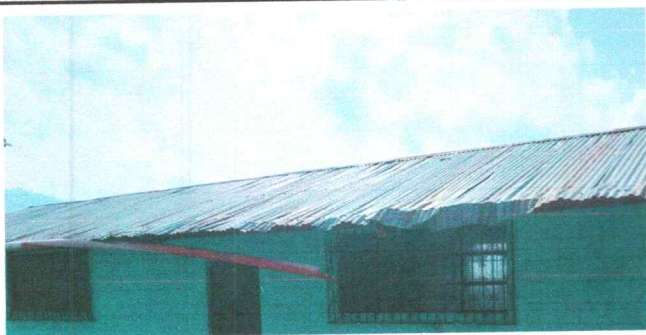
Foto 5: Canales y bajadas de agua pluvial
