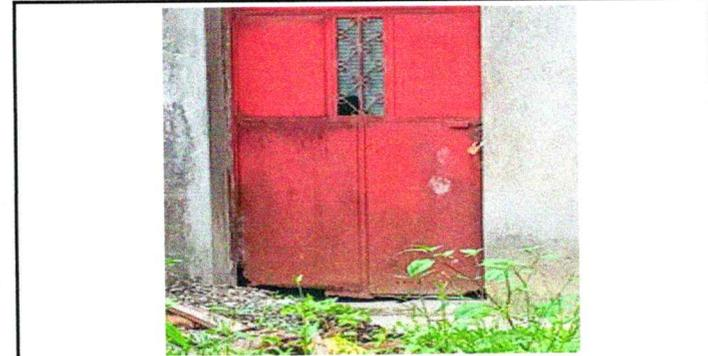
Foto 6: Sustitución de puerta en servicios sanitarios 1.85 x 0.81 metros
