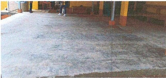
Foto 3: Sustitucion de piso de concreto
